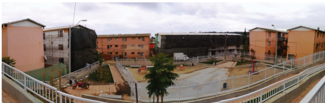
Figure 2. Villa under intervention by the Programa de Regeneración de Conjuntos Habitacionales . Source: RUCAS files. undefined
